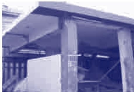
Daño severo en unión viga-columna.
